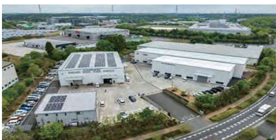
最新設備を備えた第3工場が2025年5月に竣工
