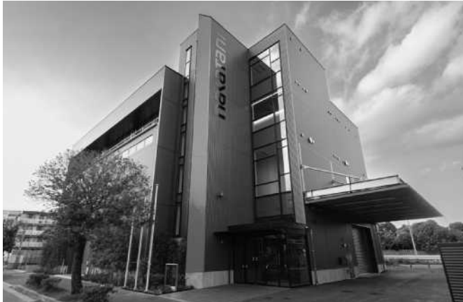
中谷機工が移転、開設した千葉幕張事業所。
